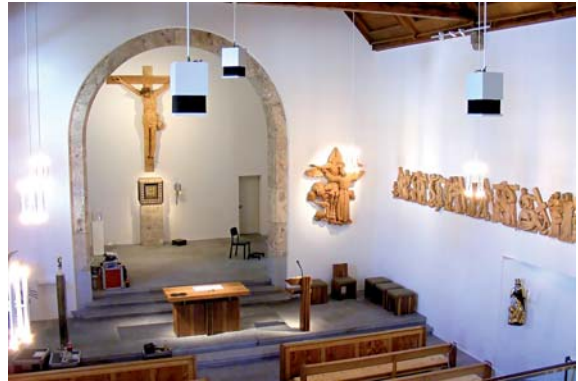
Klosterkirche Brig (CH): Installation mit 3 BenkCube DS8/ 1 SU18
